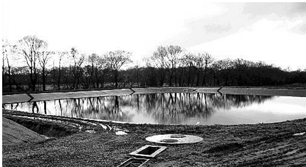
Ci contre : réception des travaux de lagune en Novembre 2002
