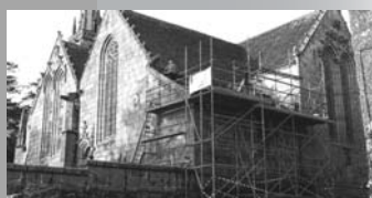
Travaux en cours
