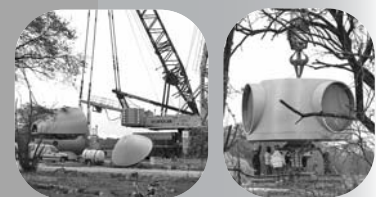
Les grues AC 500 «Lisa» et AC 700 «Marceau», de Dufour, qui assurent les montages des anneaux béton.
