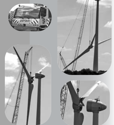
La grue LG 1750 "lubin" assure le montage des parties "hautes".
