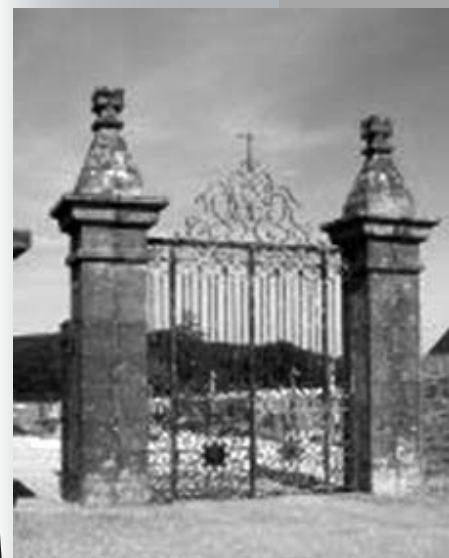
Le projet de repose du portail de l'église
